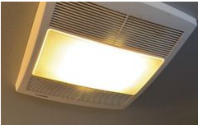
Bathroom exhaust fan
